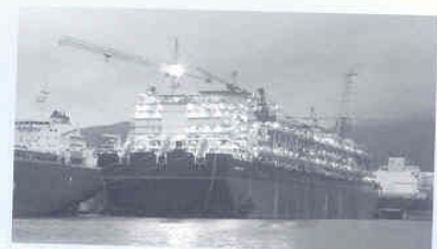
▲[사진 4] 야간 안벽작업 광경
