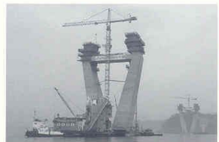
▲[그림 2] 주탑 시공 전경
