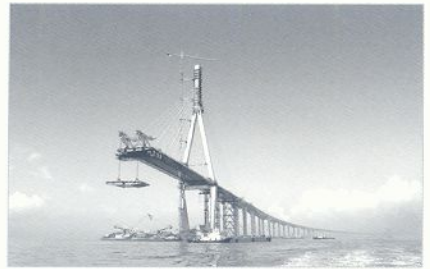
▲ 사장교 주경간 설치
