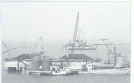
▲ 주탑 기초 콘크리트 타설
