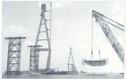
▲ 사장교 강상판 대블럭 설치
