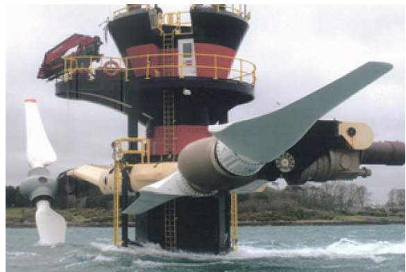
[그림 1] MCT-Siemens사의 SeaGen (1.2MW)
